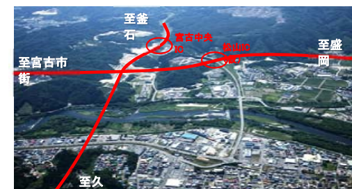
久慈方面から松山IC(仮)付近を望む
