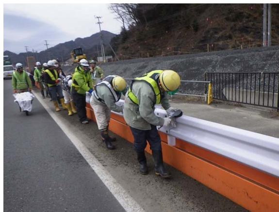
▲ガードレール清掃状況
