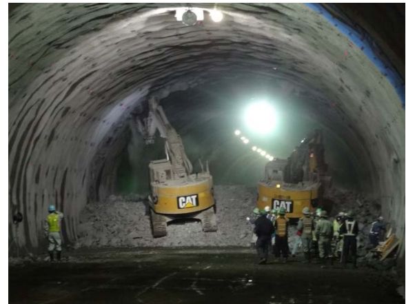
▲切羽の前で掘削状況の見学
