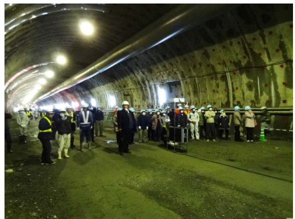
▲トンネル坑内の見学
