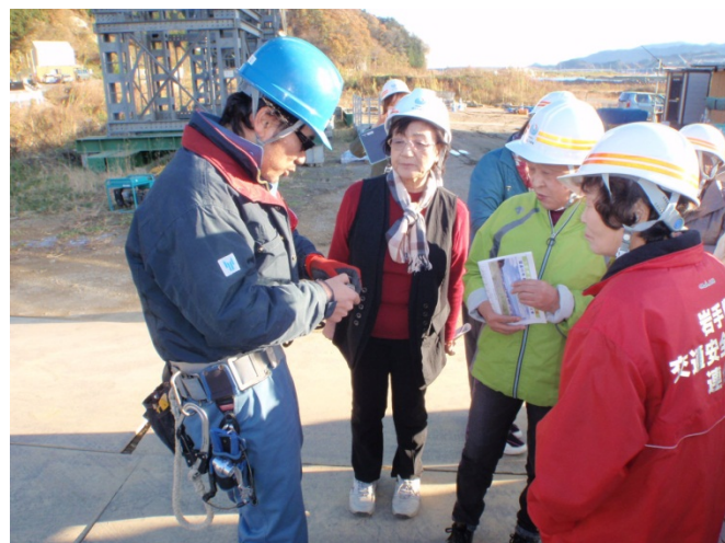
▲現場視察状況
