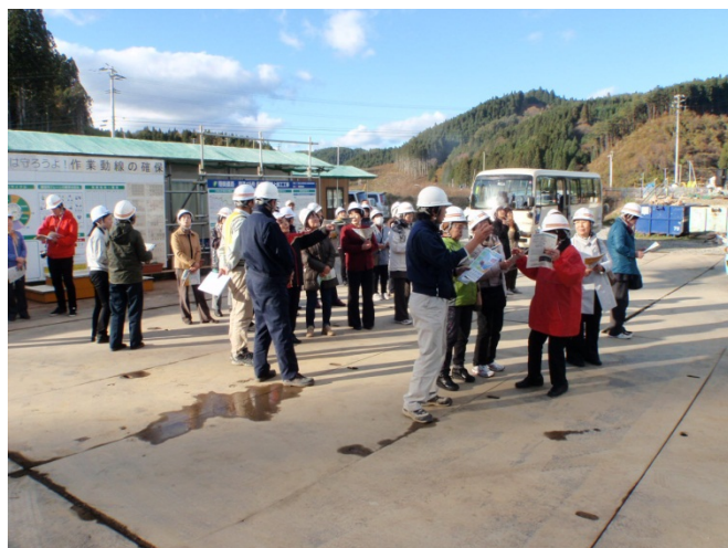
▲現場視察状況
