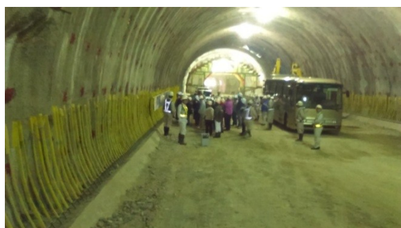
▲トンネル工事概要説明、坑内見学
