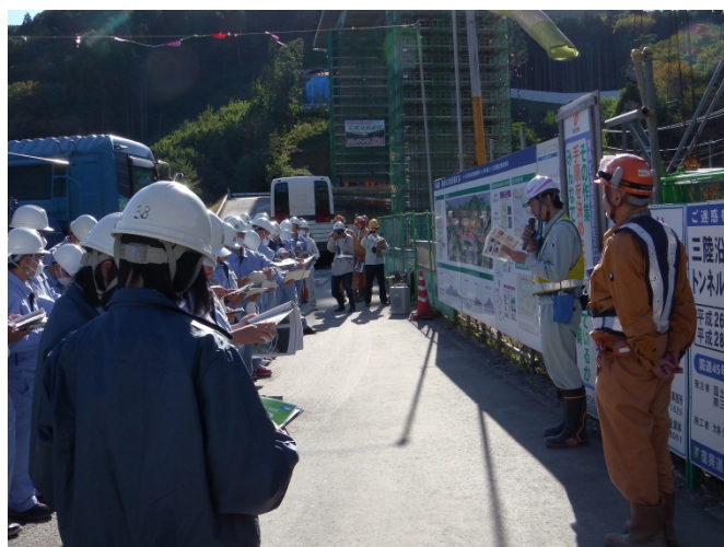
▲現場研修状況
