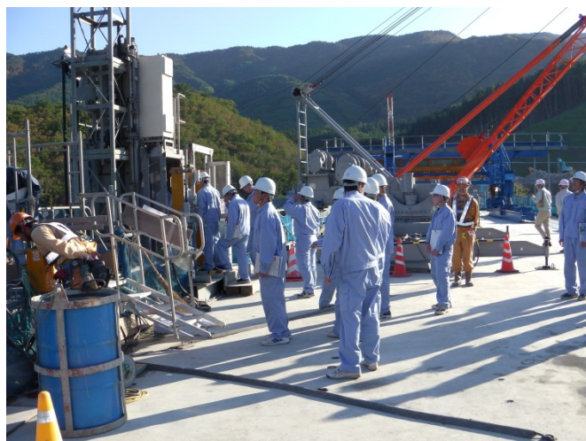
▲現場研修状況
