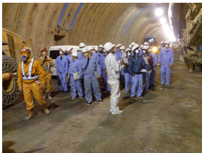
▲現場研修状況
