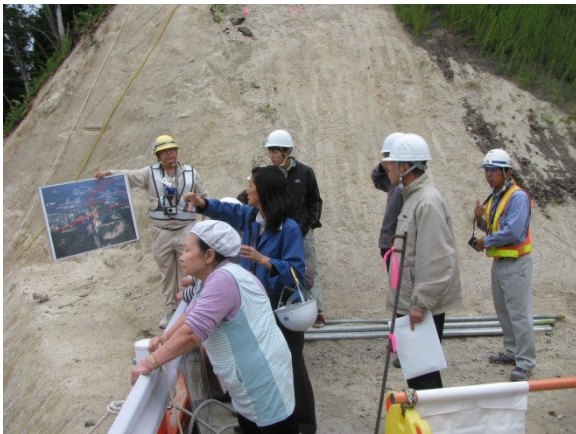
▲(閉伊川橋)工事の説明を受けながら見学
