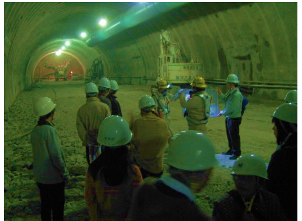
▲(小山田トンネル)坑内を見学
