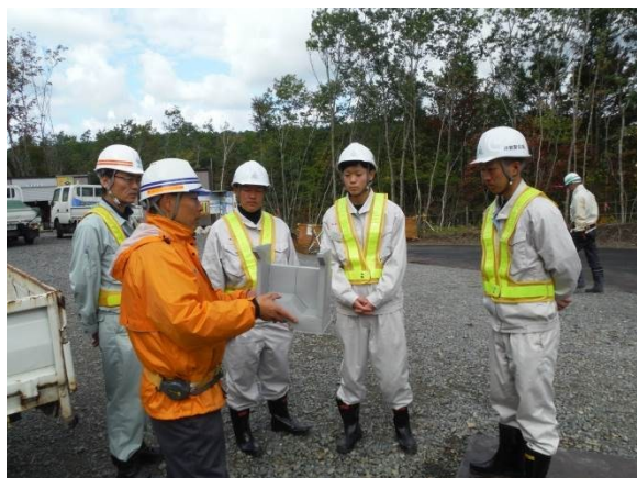
▲工事担当者が模型を使って橋台の施工概要を説明
