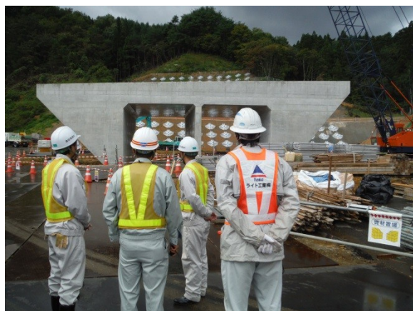
▲施工完了のボックスカルバートを見学
