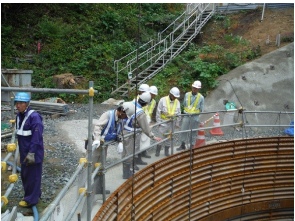
▲ケーソン基礎鋼製型枠の大きさに驚嘆
