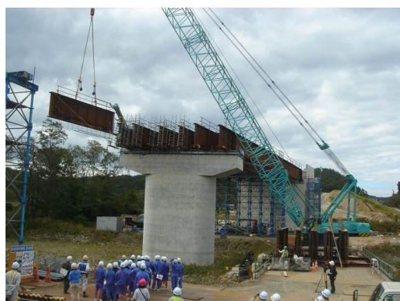
▲橋桁の架設状況を見学
