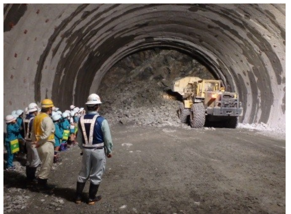
▲切羽の前で掘削状況見学
