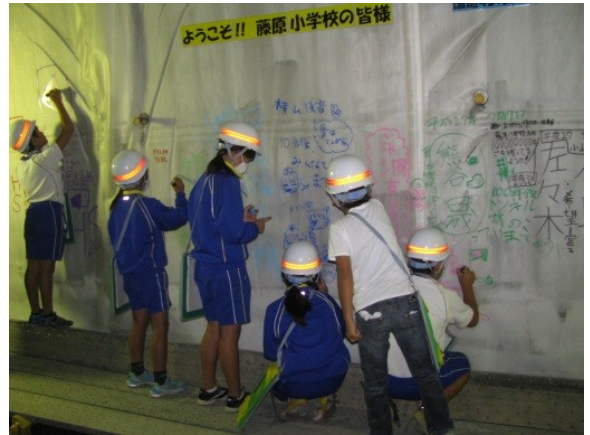
▲(小山田トンネル)防水シートに記念のメッセージ
