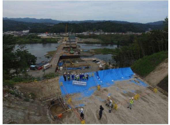
▲(閉伊川橋下部工)閉伊川右岸高台より見学
