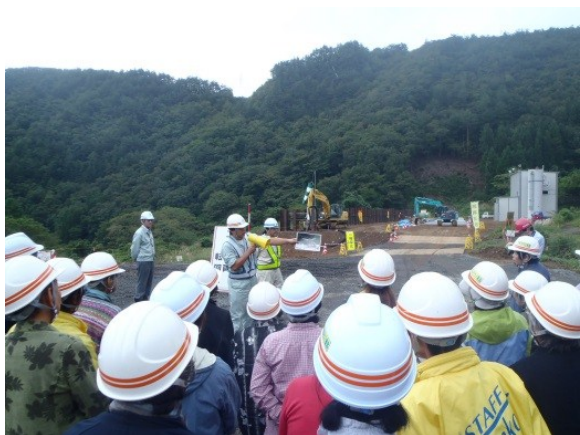
▲（腹帯地区道路工事） 担当者より工事の説明
