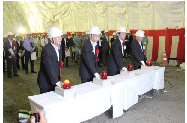
▲柏木平第2トンネル貫通発破
