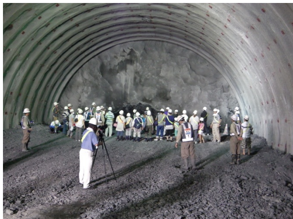
▲ トンネル坑内見学
