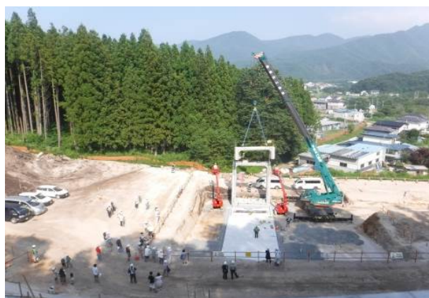
▲ボックスカルバートの据付状況見学
