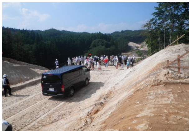
▲道路の盛土状況を見学
