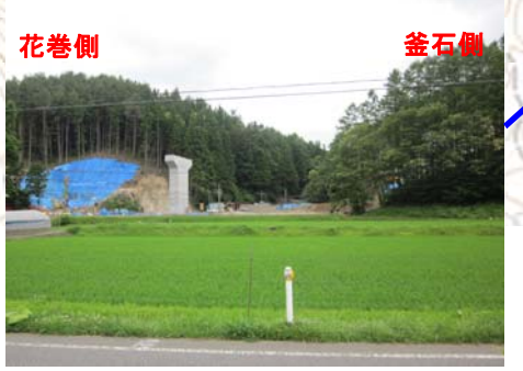
STA.42付近(花巻方向を望む)
