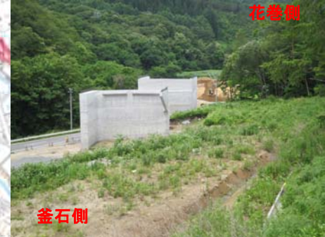
STA.47付近(花巻方向を望む)
