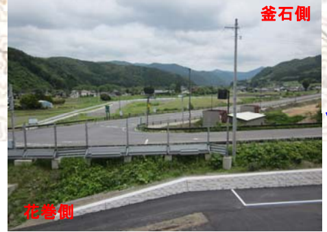
遠野住田IC付近(釜石方向を望む)
