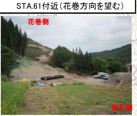
鍋倉トンネル(仮) L=181m
