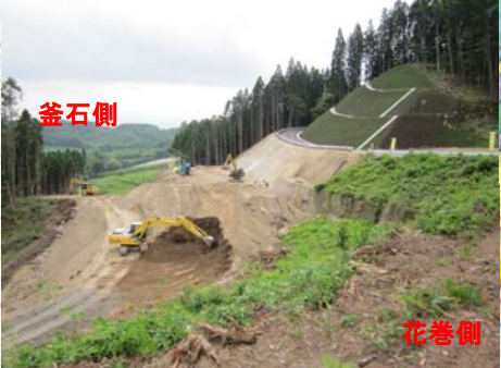
STA.98付近(釜石方向を望む)
