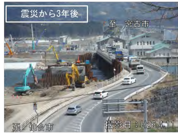
▲仮復旧で対応している気仙大橋
