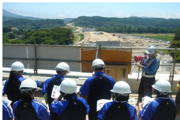
▲工事概要の説明
