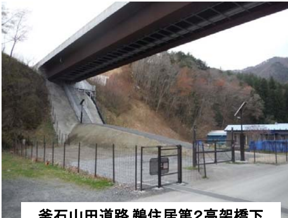
釜石山田道路 鶺住居第2高架橋下
