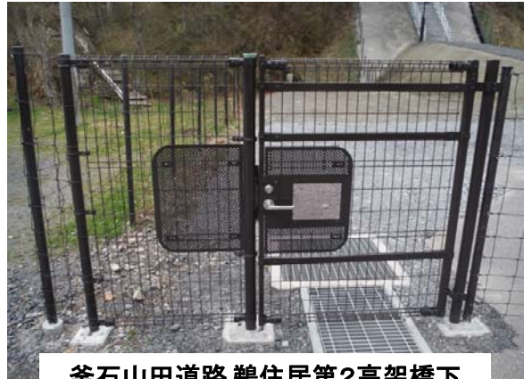
釜石山田道路 鶺住居第2高架橋下
