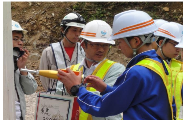
▲コンクリートの品質強度の測定作業体験
