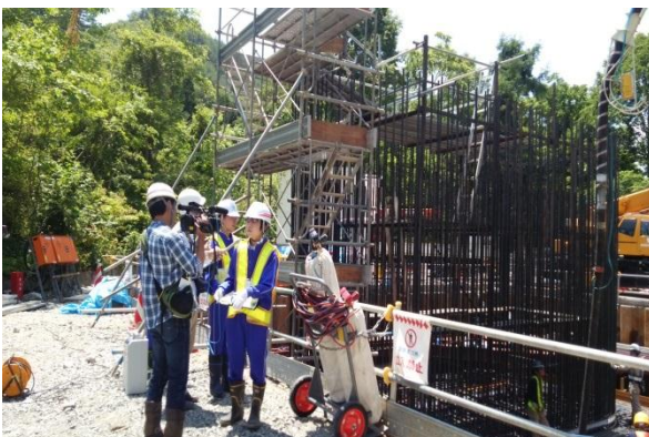
▲鉄筋組み立て作業の見学
