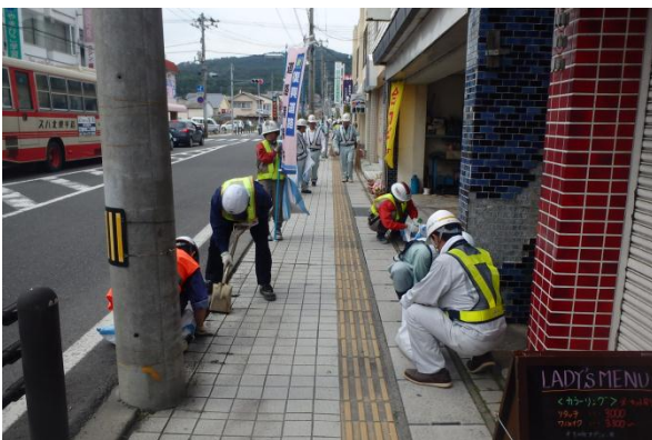
▲平板舗装の目地部の清掃
