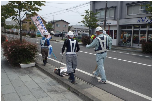
▲清掃機械による側溝の清掃
