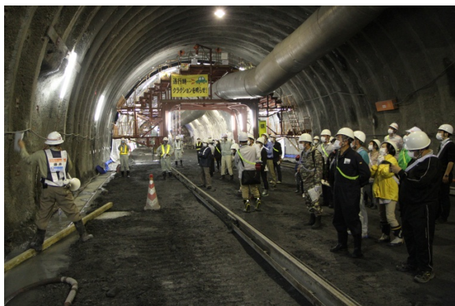
▲ トンネル坑内見学
