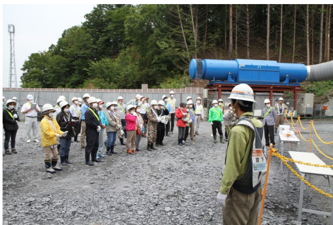
▲ 工事概要説明
