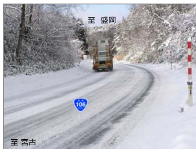
【写真② 急カーブ区間の連続】
