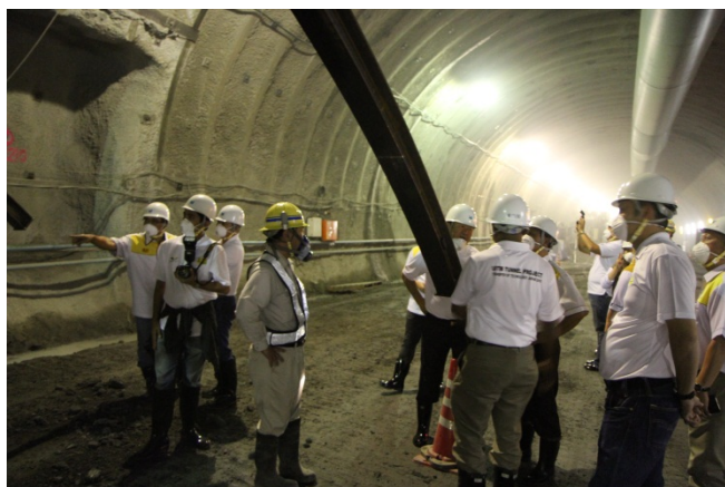
▲ トンネル工事視察
