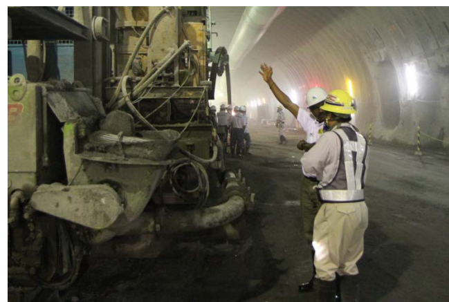
▲ トンネル工事視察
