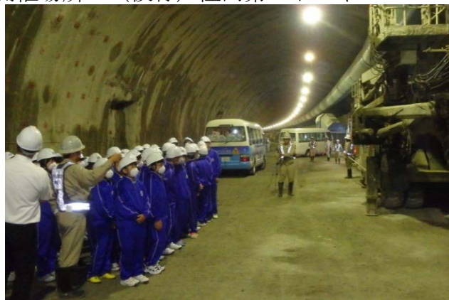
▲トンネル工事に使用する機械について学習
