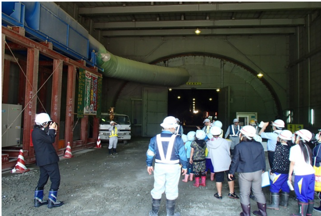
▲トンネル坑内の見学
