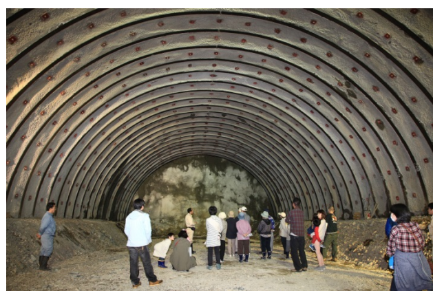
▲切羽付近でトンネルについての説明
