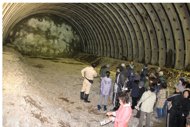
▲トンネル坑内の見学
