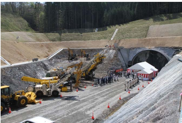
▲会場全景(トンネル坑口)
