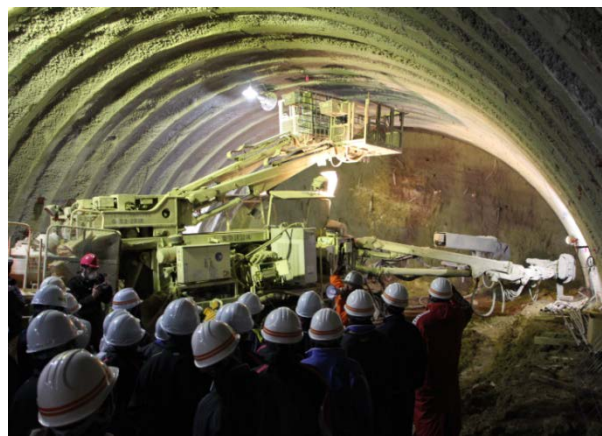
▲トンネル最深部(337m地点)で工事について説明
