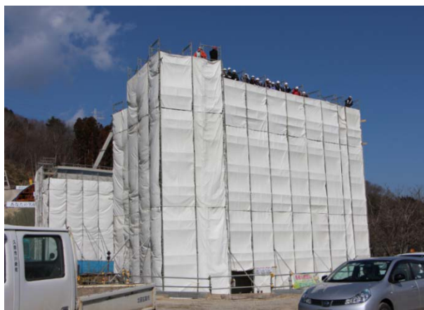
▲橋台(高さ15m)に登って工事の様子を一望
