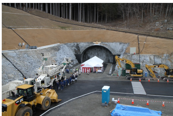
▲会場全景（トンネル坑口）
