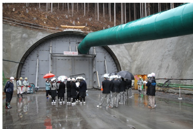
▲トンネル発破体験 (発破の瞬間は、トンネルの外で体験)
