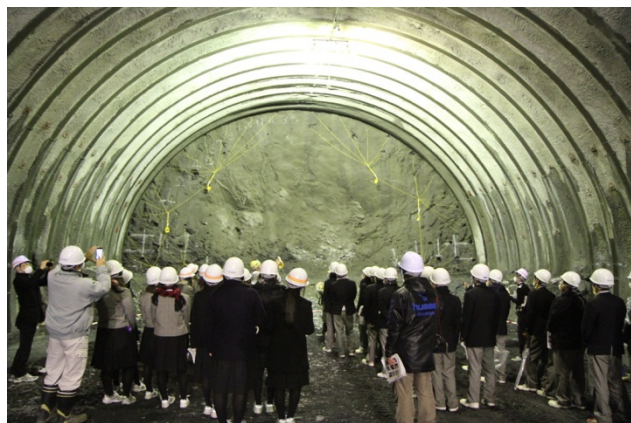
▲トンネル発破体験 (発破前の切羽を見学)
