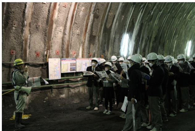
▲工事概要説明、トンネルの作り方など
