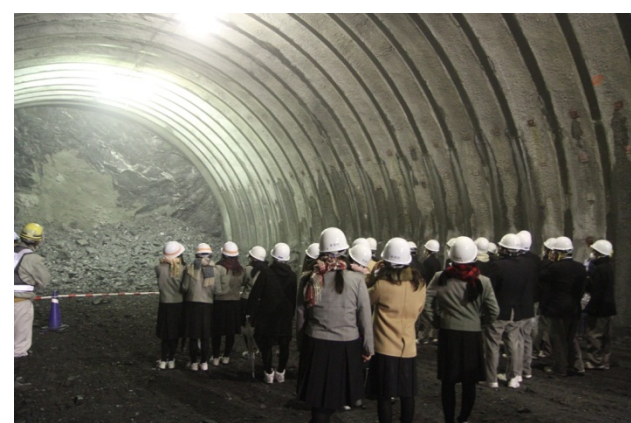
▲トンネル発破体験 (発破後の切羽を見学)
