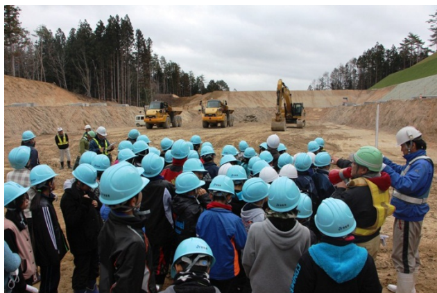
▲大型機械が並ぶ工事現場の見学
