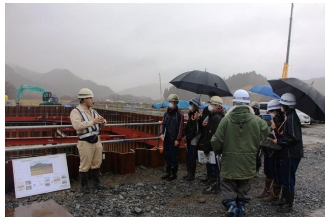
▲橋梁の下部工工事の状況を見学
