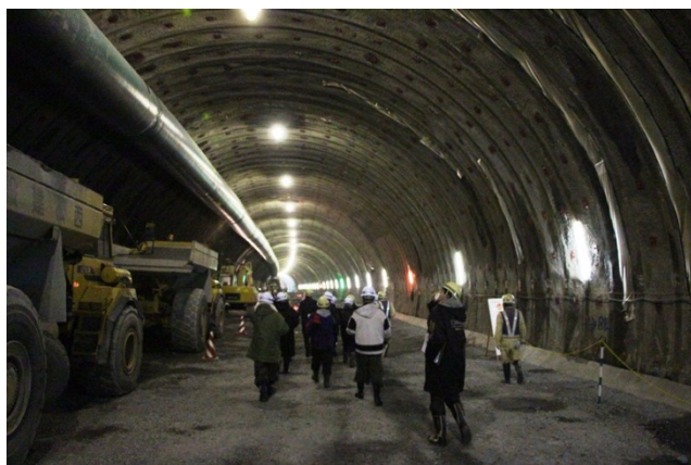
▲長いトンネルの奥まで進みます
