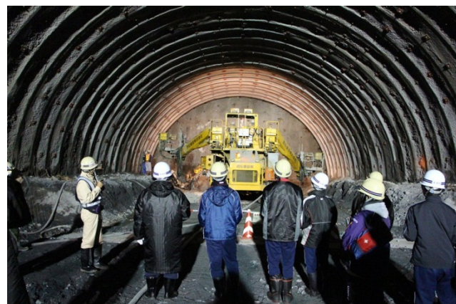
▲現在掘削をしている最深部を見学
