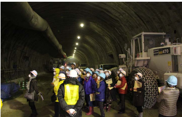
▲(仮)山田第2トンネル内部で工事状況等を説明
