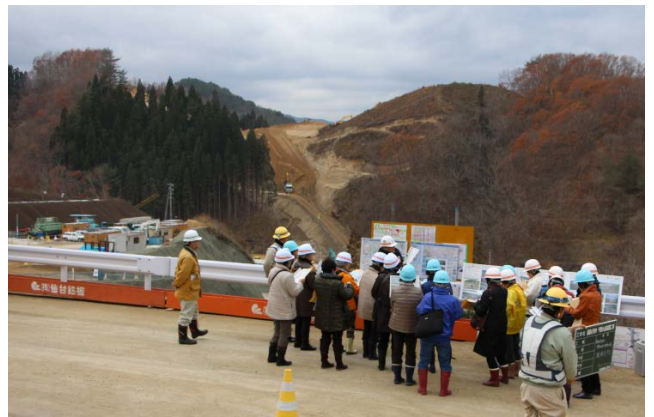
▲千徳小山田道路工事現場(宮古中央IC付近)
