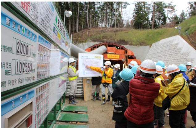
▲(仮)山田第2トンネルの前でトンネルの概要説明
