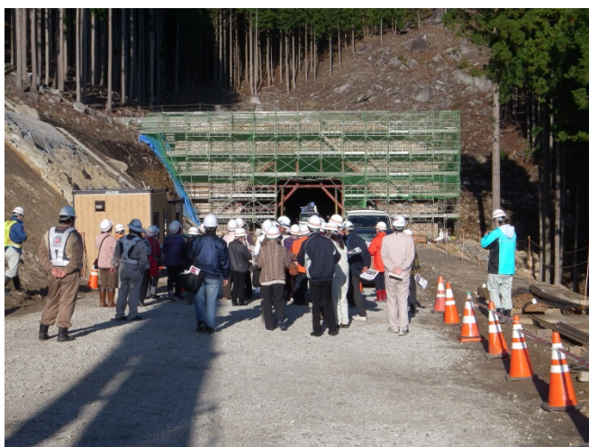
▲現場視察状況
