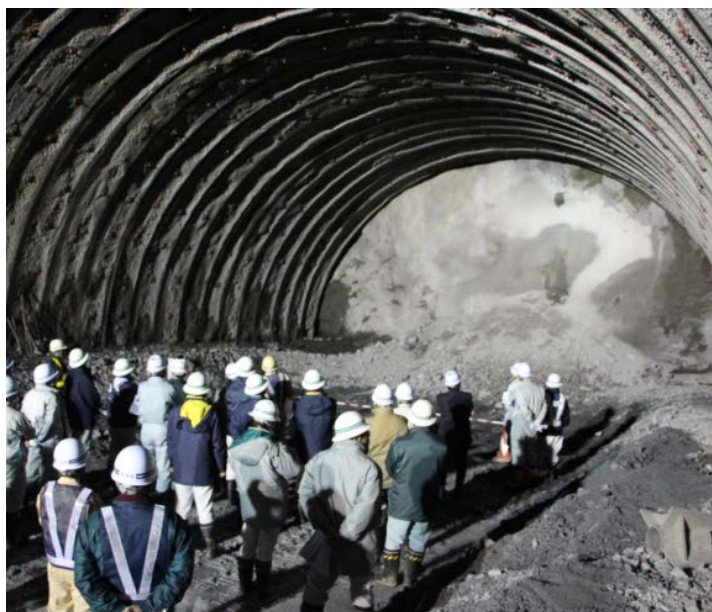
▲（仮称）小本トンネル掘削最深部で工事説明
