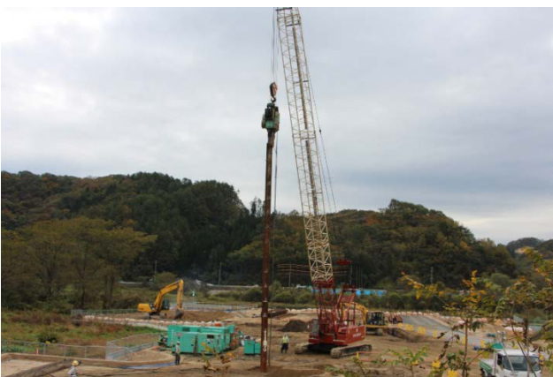
▲大型クレーンによる杭の打ち込み作業を見学
