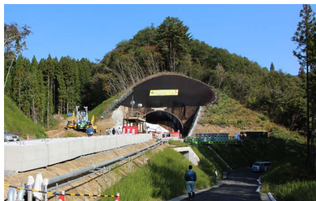
▲安全祈願祭会場の山口第2トンネル南側坑口
