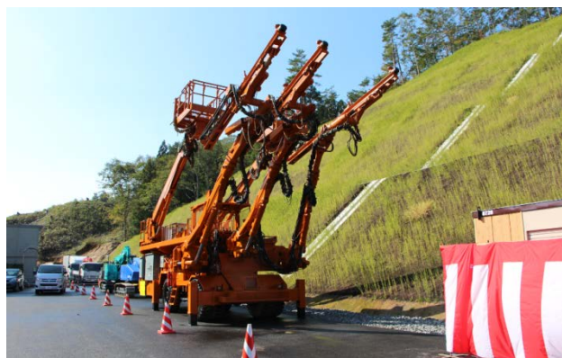
▲トンネル掘削に使用する大型機械
