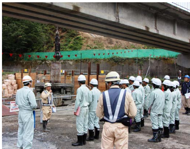
▲新小本大橋の下部工工事を見学
