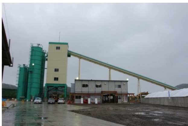
▲8月31日(日)に稼働を開始する公共プラント
