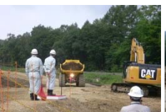
▲工事着工（1.4m 3 バックホウ、30tダンプトラック）
