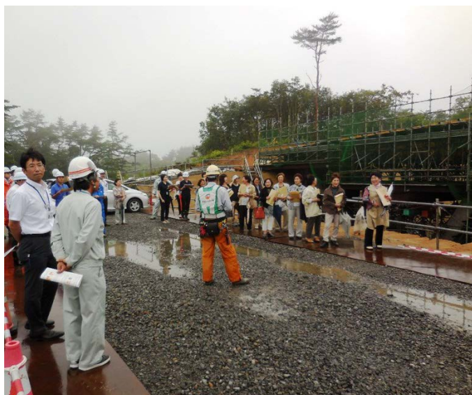
▲工事現場担当者よりこ道橋工事について説明
