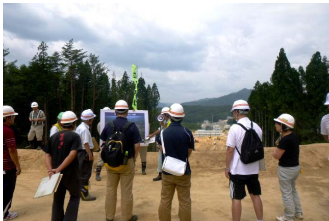
▲豊間根地区の工事状況を説明
