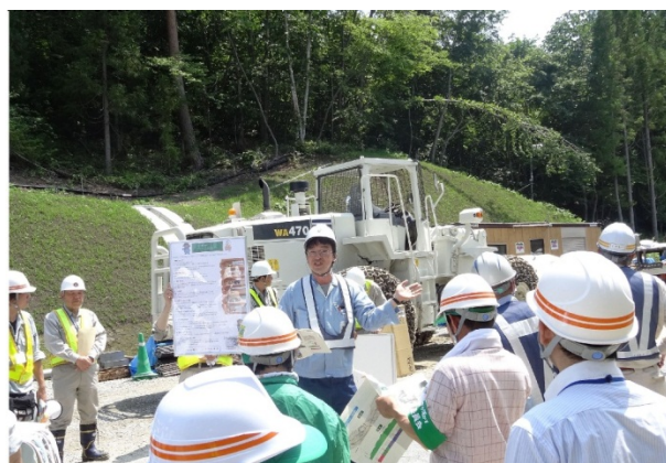
▲山田第2トンネル前でトンネルの掘削方法を説明
