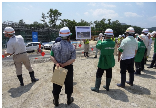
▲豊間根川橋の下部工工事の状況を説明
