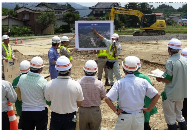
▲荒川地区の工事状況を説明
