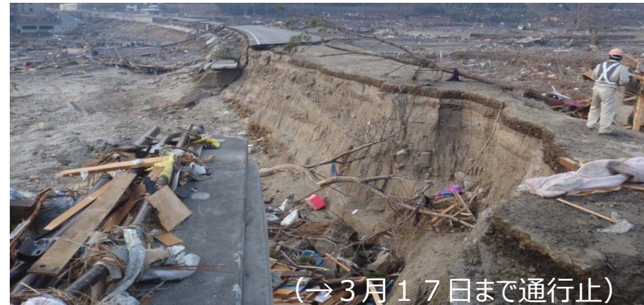
▼津波により寸断された国道 ▼写真① 国道45号大槌町浪板地区 (平成23年3月12日)
