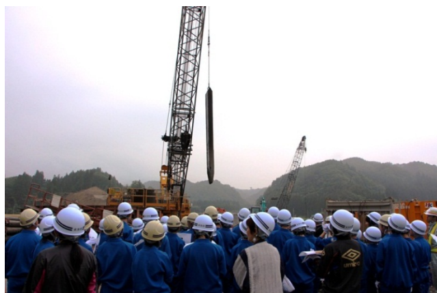
▲橋の基礎杭を打ち込む作業に大興奮！
