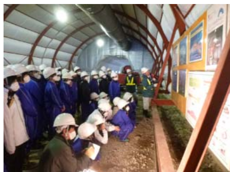
▲三陸国道事務所 小滝建設監督官が トンネルの掘削方法を説明
