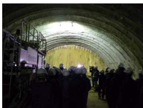
▲現地点でのトンネル掘削最先端 <255m>地点 残り39mです
