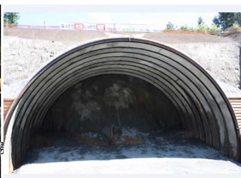
▲田老第6トンネル終点側（北側）坑口 いよいよ本格的に掘削工事が始まります
