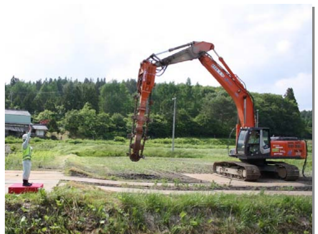
▲工事着工の指示
