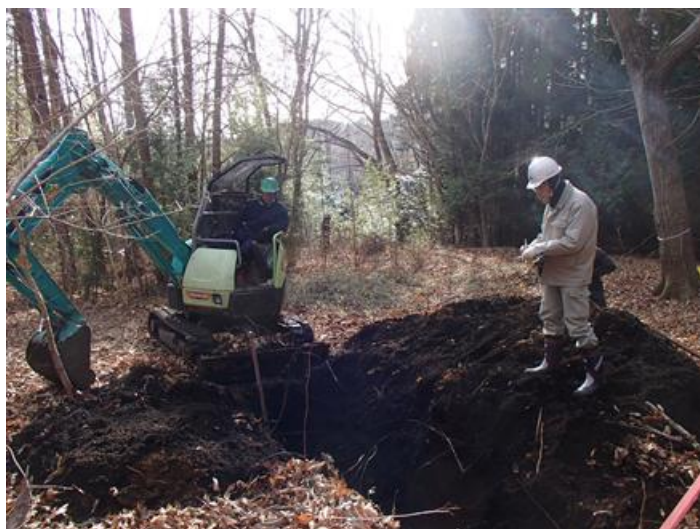
▲ 12/21 浪板地区試掘状況
