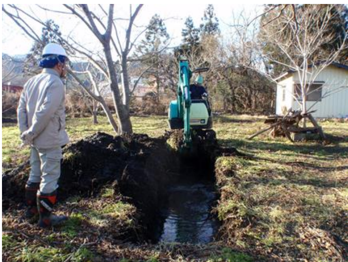
▲ 12/10 大槌地区試掘状況
